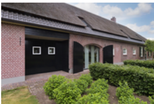
Afbeelding 23: Dubbele woonboerderij - Spanjers Architect
